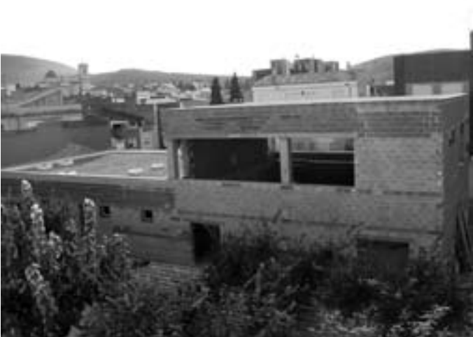
Nou edifici "en marxa".
