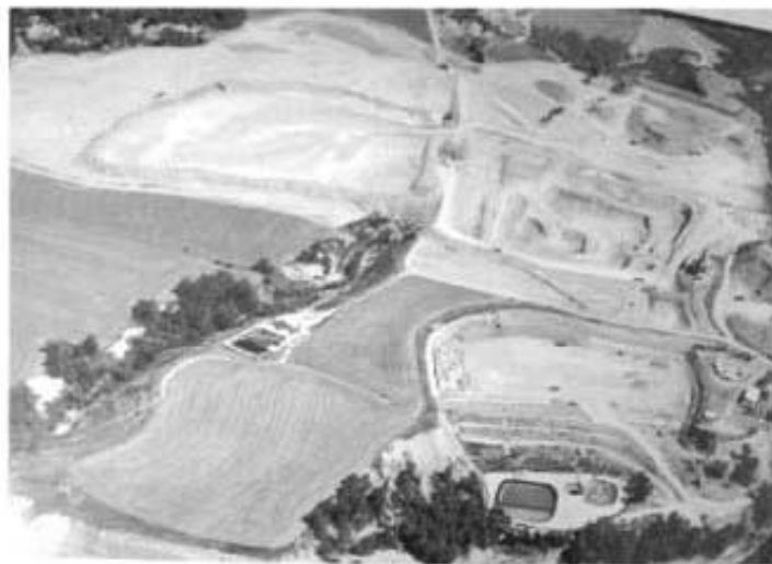
Dipòsit controlat de Classe III de Castellolí
