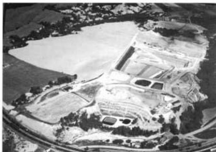
Dipòsit controlat de Classe III de Castellolí
