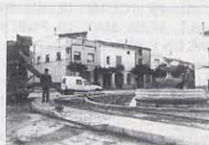
Obra de remodelació a la Plaça Cervantes.
