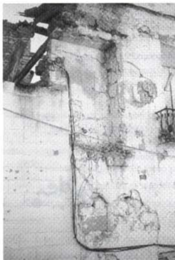
Espai de la façana de l'Hospital de pobres, on s'observa el nínxol que cobertjava el plafó ceràmic de la Santíssima Trinitat
