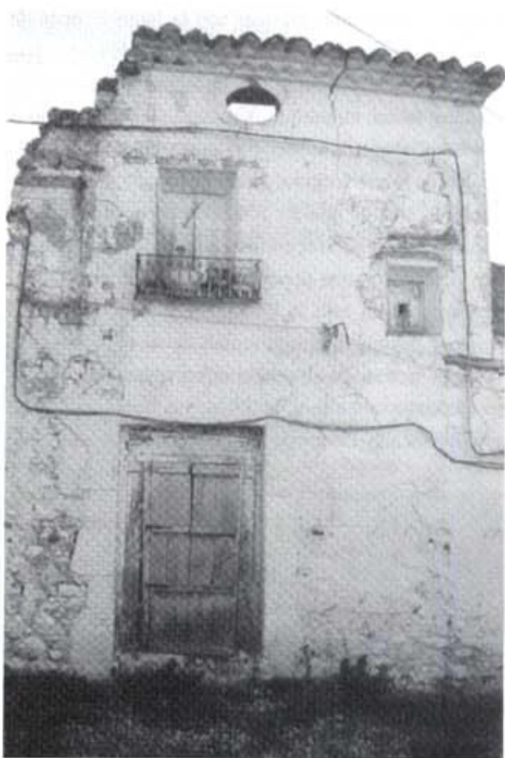
Antic Hospital de les Coves de Vinromà
