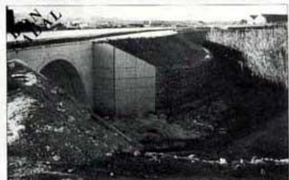
Les obres del desviament quasi finalitzades
