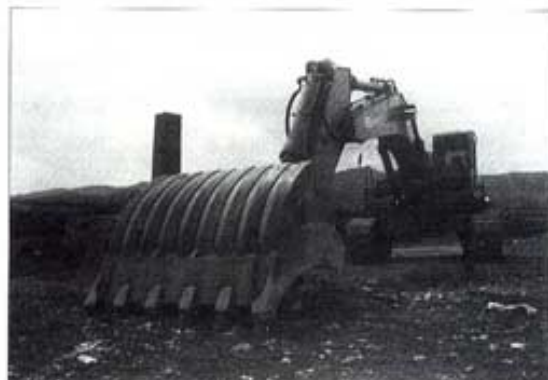
Obres del desviament (Foto LENYO)
