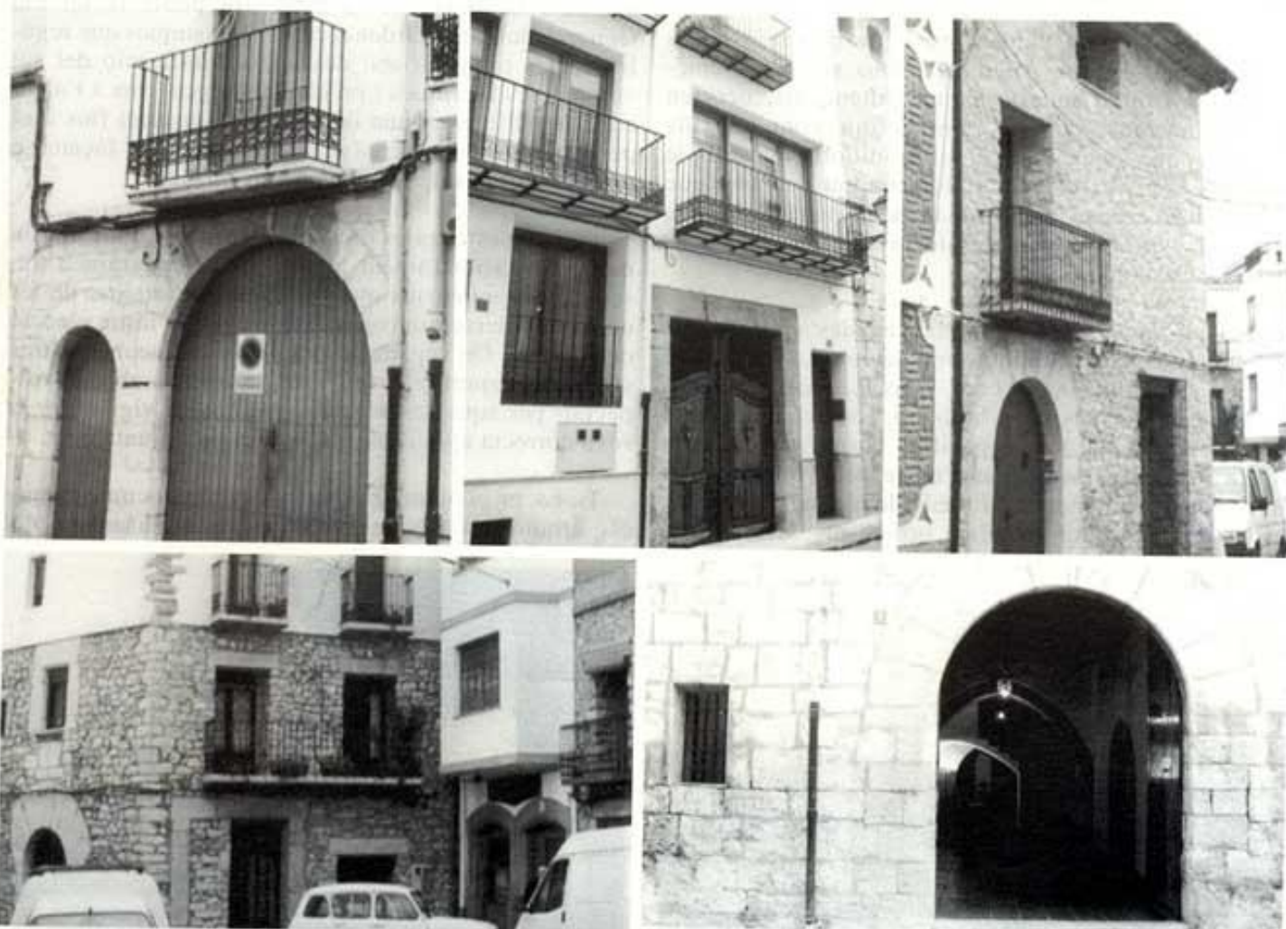
Edificacions rehabilitades a Sant Mateu i Tirig. L'ús de la pedra picada, blocs rectangulars i regulars de considerables proporcions, s'utilitzava sempre per a deixar-lo a la vista, a diferència de la fàbrica de maçoneria on s'usaven pedres irregulars i petites que anaven destinades a cobrir-se amb ciment, calç i pintura. Malauradament, en els habitatges convencionals, la pedra picada s'utilitzava tan sols per emmarcar portes i finestres o reforçar cantonades, a excepció dels edificis amb major presència i notorietat...
