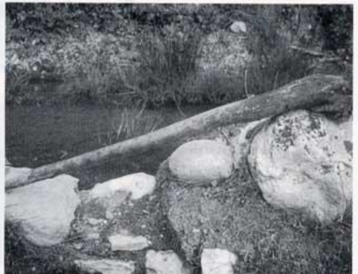
Basseta de Tapisso. Estaca per regular el cabal de sortida.
