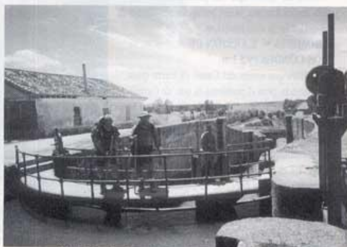
FOTO 16. Resclosa del Canal de Castilla a Frómista.
