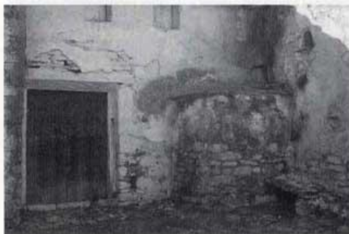
Forn adossat a la casa d'un mas.
