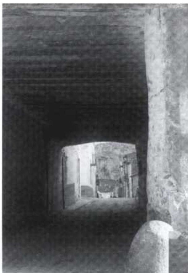
El Portal. Entrada del carrer la Moreria. 1964
