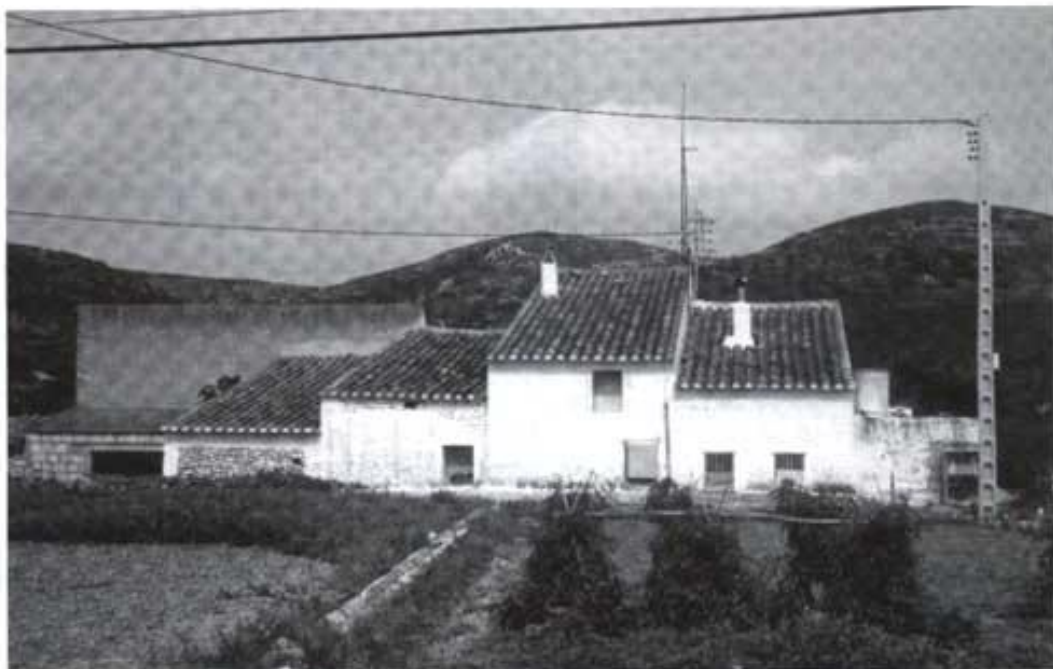
La Sénia Granell, vista des de la carretera.
