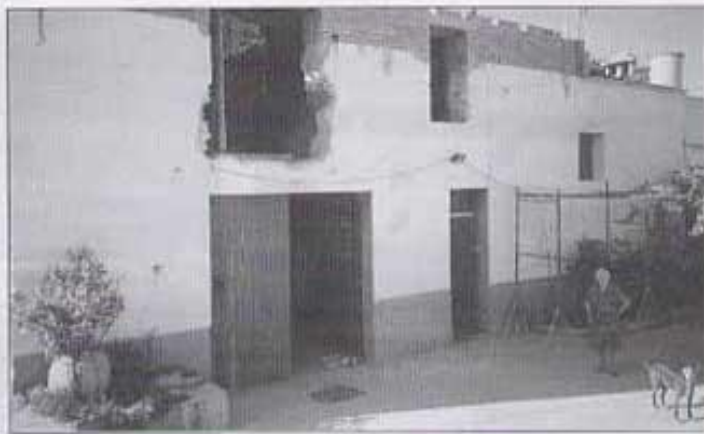
Façana del Mas, ara en obres.
