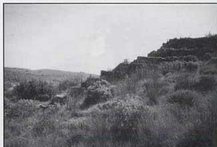
El perfil esglaonat de la rampa.
