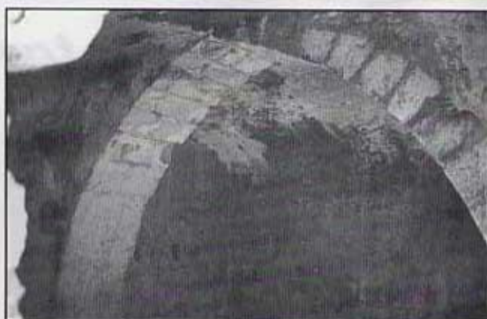
L'arc de mig punt reforça la sala de moldre.
