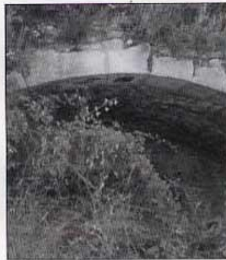
Un arc rebaixat reforça la construcció. (Molí Bellés)
