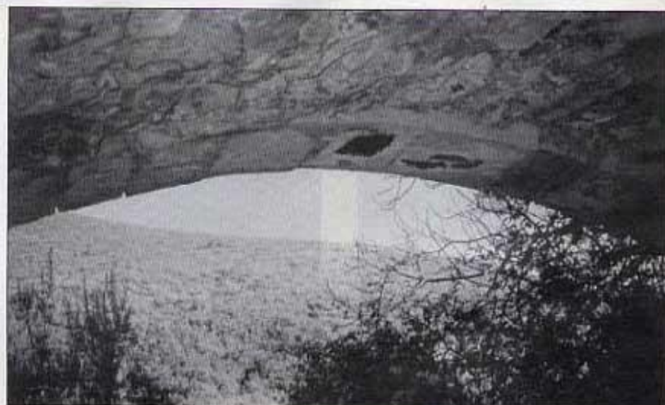
L'arc rebaixat des de la sala de moldre. (Molí Bellés)
