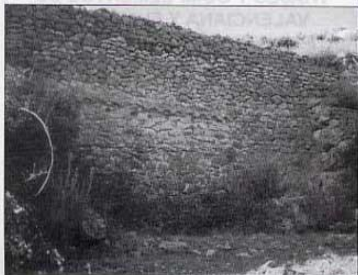
A la paret s'aprecien els forats on es recolzaven els cabirons de l'estable.
