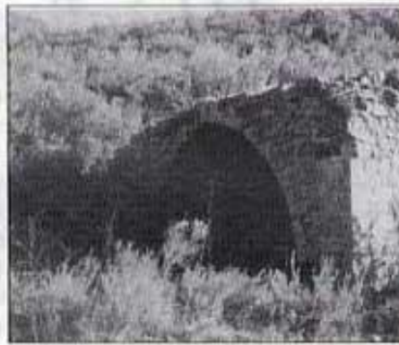
Malgrat que mig molí ja no hi és, l'arc segueix reforçant la sala de moldre.
