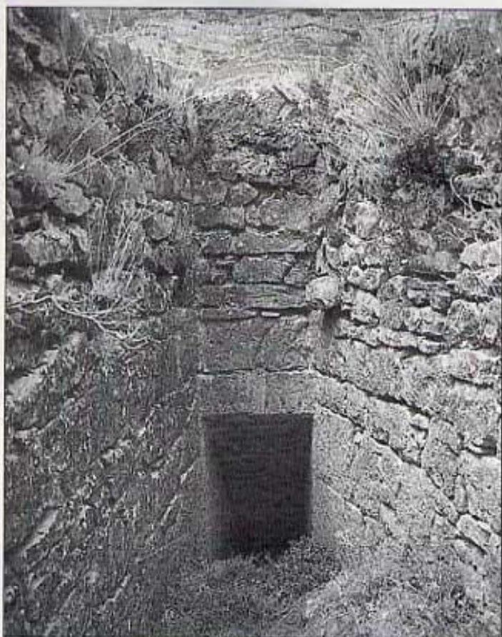
Boca de la rampa des de la bassa estant.
