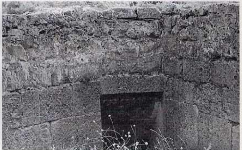
Boca de la rampa. 32
