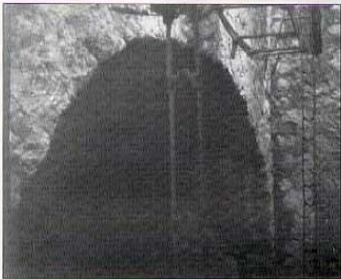
Interior d'una sènia fotografat des de la cava. Es veuen els arcs que aguanten la sènia.
