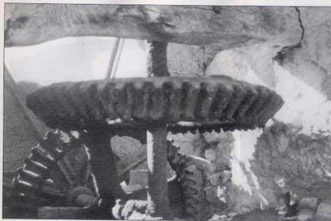
Dues rodes dentades formen els engranatges. Dalt es veu un dels travessers que subjecten l'arbre. A la dreta es pot veure el mosso.
