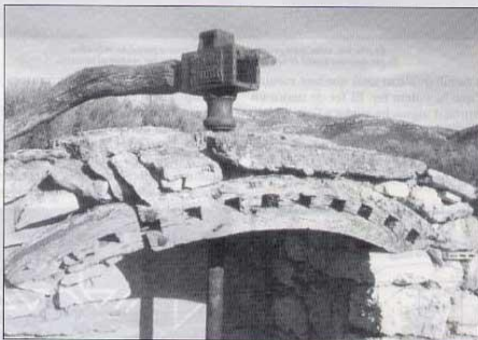
En el cap de l'arbre dels engranatges es pot veure la marca del taller de foneria. Fixeu-vos també en el llindar. Està fet amb un tros de roda de l'antiga sènia de fusta.
