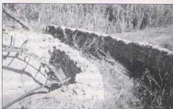
Les sènies amb una mota alta, per a resguardar al animal de possibles caigudes, tenien uns pilars de pedra per la volta i barres de fusta horitzontal de pilar a pilar, o una paret com aquesta.
