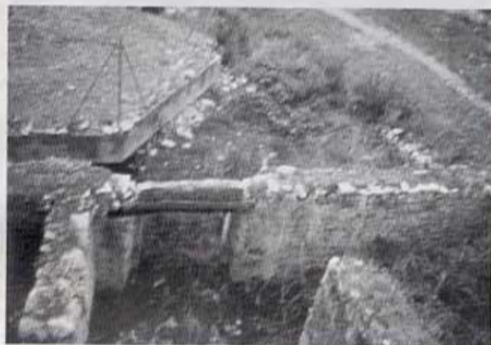
La paret de la depuradora quasi toca el molí
