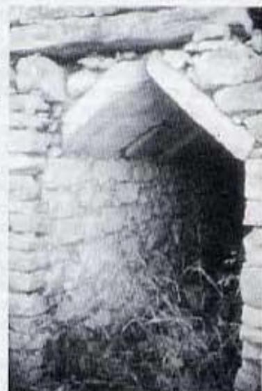
Desguàs per a facilitar l'evacuació de l'aigua
