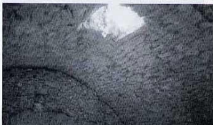
Coberta de la Nevera de la Font dels Regatzols (Ares)
