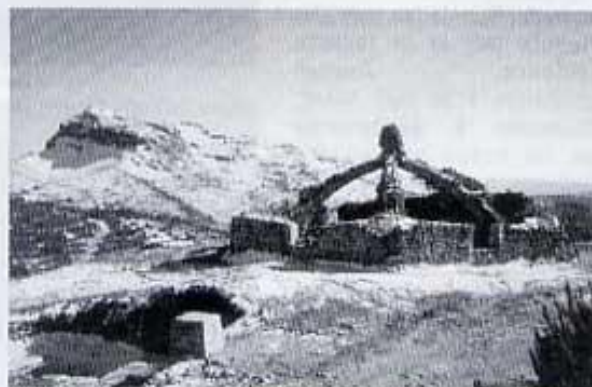
Plataforma que envolta la Nevera Gran (Serra de Mariola) per a facilitar la recollida de la neu
