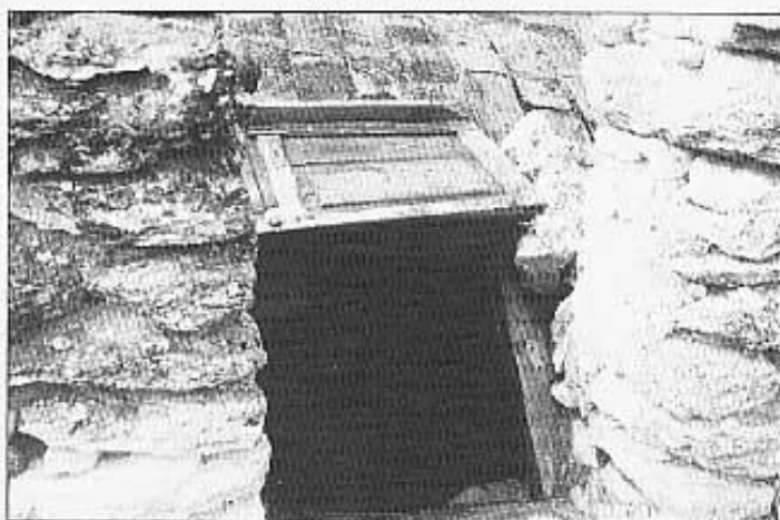
Boca de la cisterna
