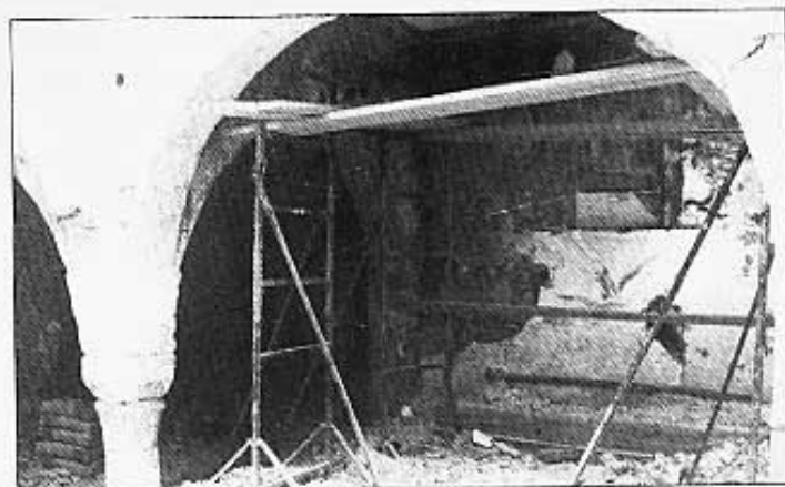
Arreglant el sostre.
