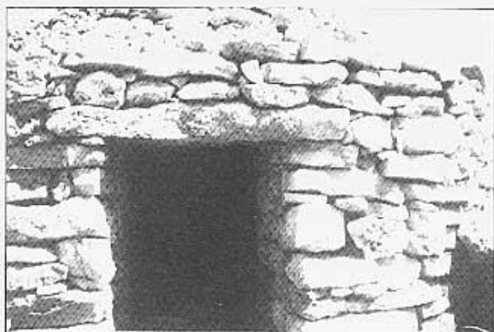
Entrada: Llosa amb mènsules de suport.
