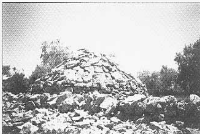
Coberta: vista exterior.
