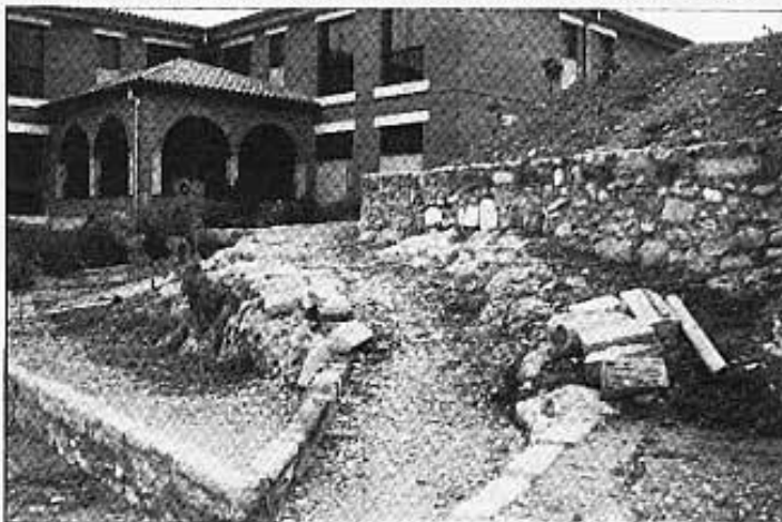
Obres dels voltants
