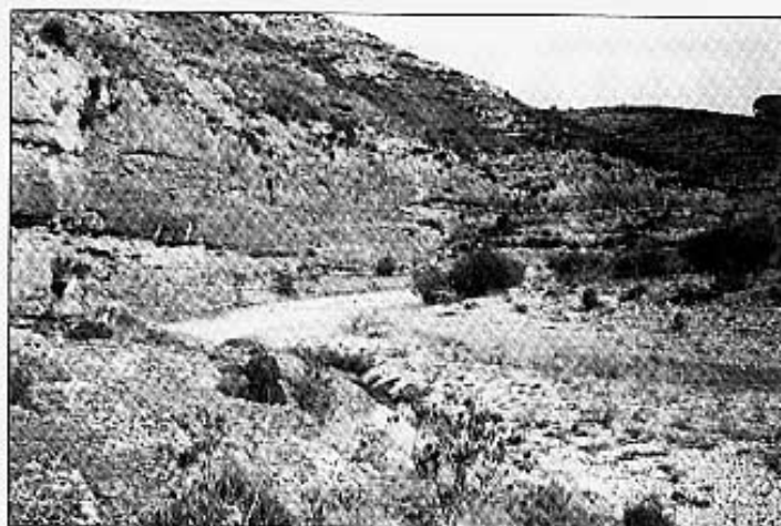
Fallida de la sèquia per velles esclavissades de roques.
