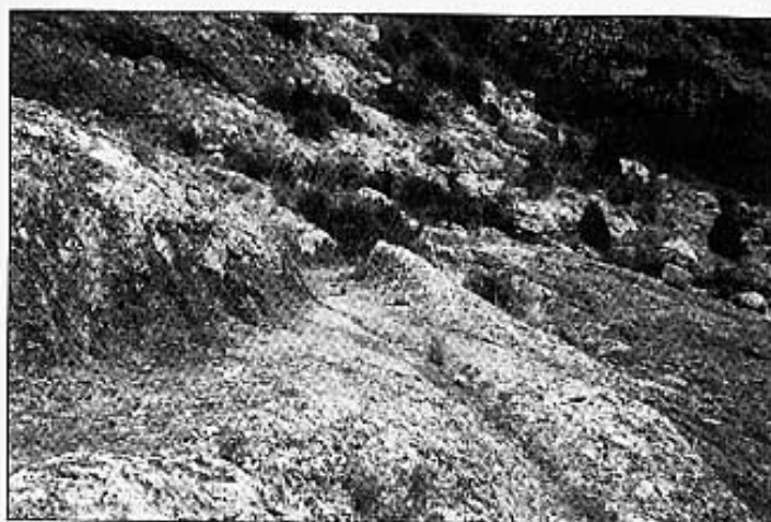
La sèquia molt erosionada.
