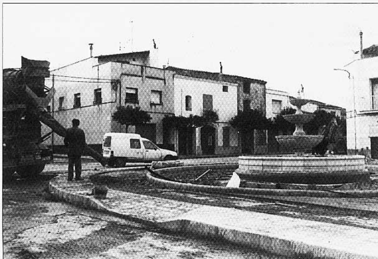
Obres de remodelació a la Plaça Cervantes.
